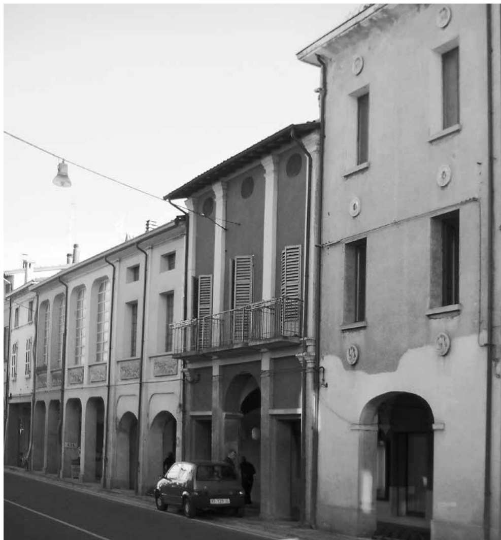
Castel Bolognese, via Emilia. Tra la facciata tripartita dell'ex chiesa del Rosario Nuovo vi sono le case che appartennero alla famiglia Amonio.
